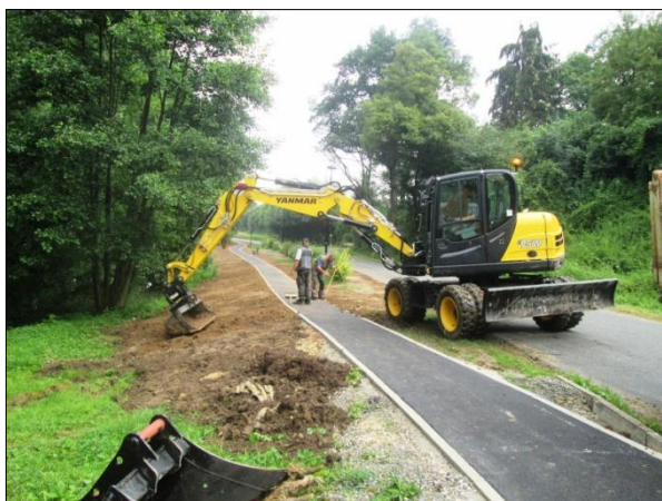
Finition du sentier piétonnier entre la Brenne et la route de Prunay : revêtement goudronné, nettoyage et stabilisation de la berge.
