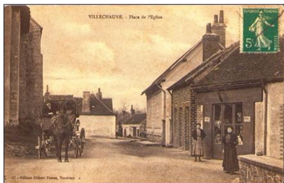
La devanture de l'épicerie et la façade de briques de la maison suivante ont disparu. Mais la grande maison du presbytère a conservé cet aspect.
