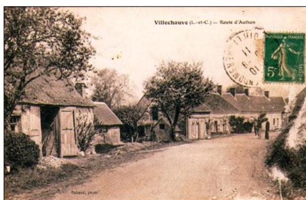
L'entrée du bourg par la route d'Authon, l'actuelle rue des Chauves. On reconnaît au fond les maisons qui ont peu changé d'aspect extérieur. La grange n'existe plus.
