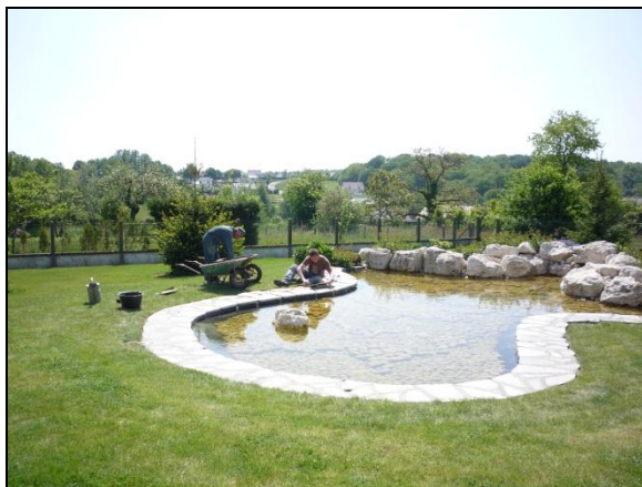
Aménagement d'un bassin auprès d'une rocaille dans un parc paysager.
