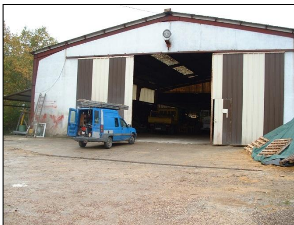
Le hangar, situé sur le même terrain que AMD Aubert au centre du bourg, abrite le matériel et les engins de chantier.
