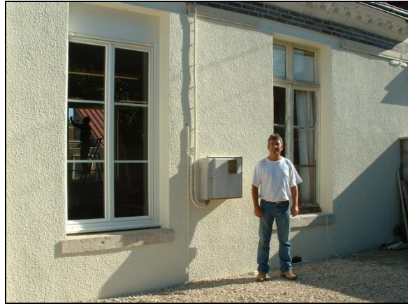
Pour comprendre ce que rénovation signifie, comparer l'état ancien à droite et l'état neuf à gauche .
