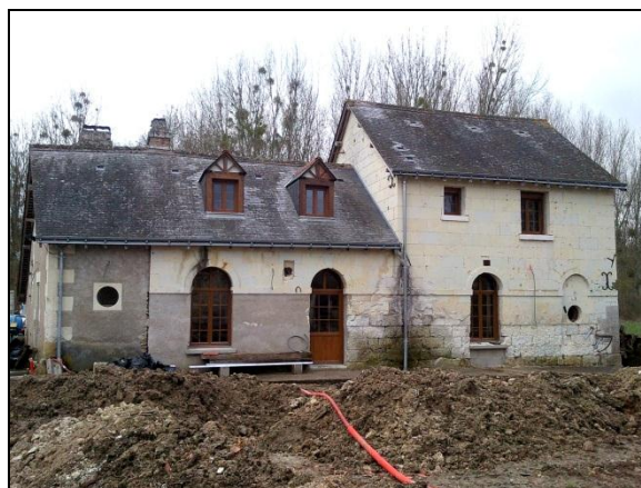
Après rénovation : le vasistas a laissé place à 2 belles lucarnes ; portes et fenêtres neuves en PVC aspect bois.
