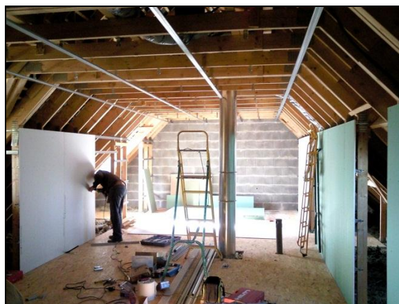
Dans cette partie mansardée, pose de cloisons isolantes pour délimiter l'espace habitable.
