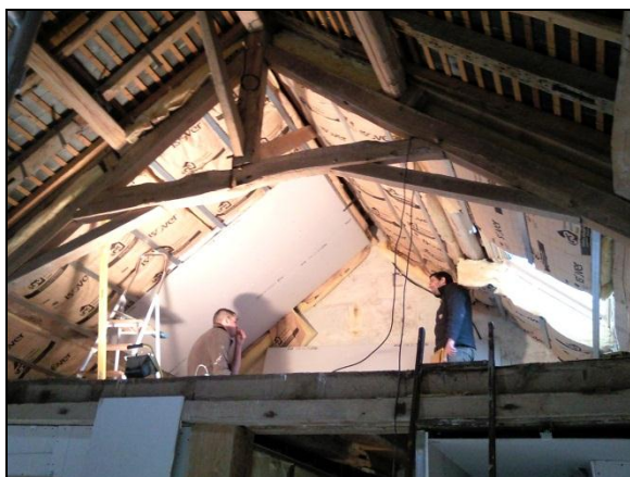
L'équipe au travail lors de l'isolation de la partie haute d'un toit : toute la surface interne sera couverte.
