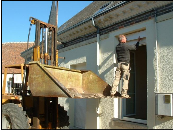
La touche finale : poser un bandeau en haut de la fenêtre pour compléter l'encadrement avec un matériau neuf.
