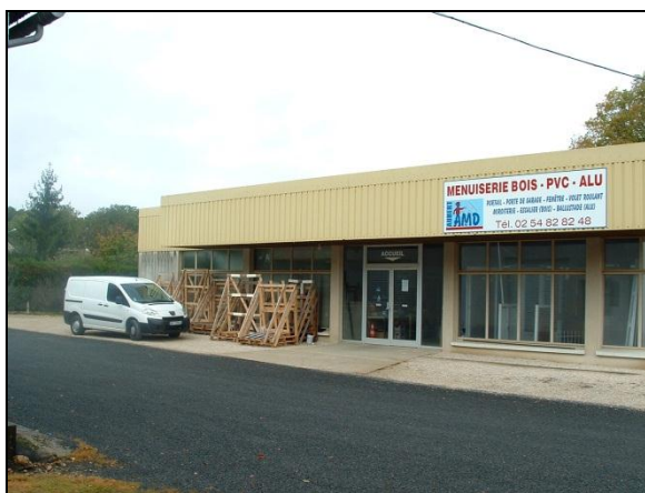
Le bâtiment abritant les bureaux et servant d'entrepôt, est situé en plein cœur de Villechauvé.
